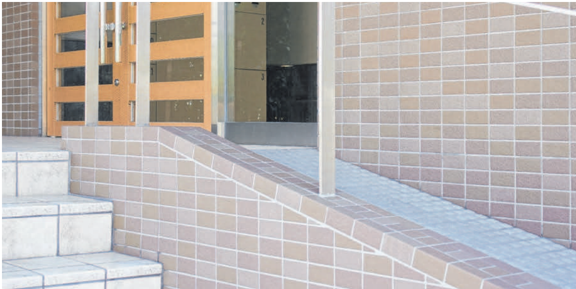
HINDERNISSE Für Personen, die nicht mehr gut zu Fuß sind, stellen Treppen beschwerliche Hindernisse dar. Fotos: dpa, Shutterstock
