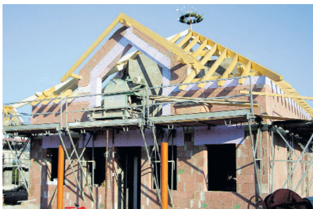
Bis das Richtfest gefeiert werden konnte, fielen stets hohe Kosten an.
