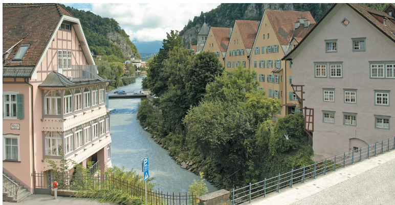
Bauwerke in unmittelbarer Nähe zu Gewässern sind bei Hochwasser gefährdet.
